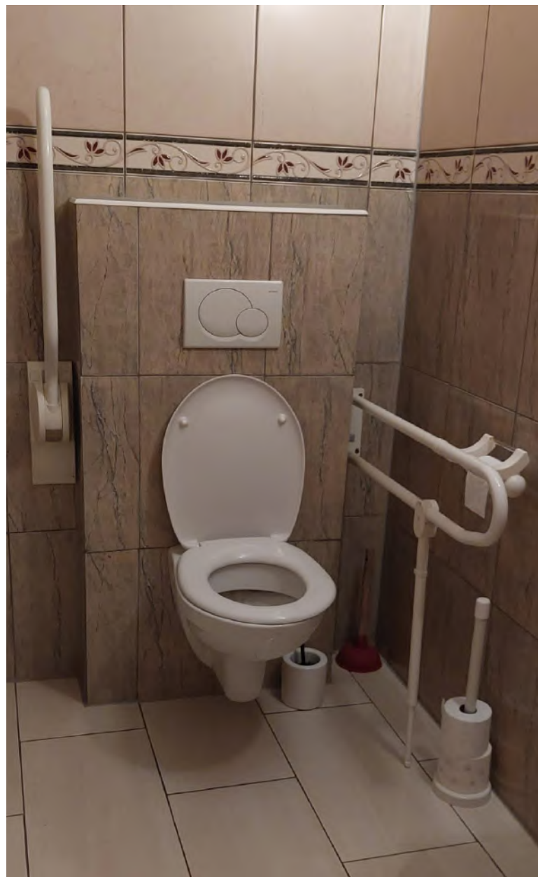
Barres d'appui dans un WC adapté
