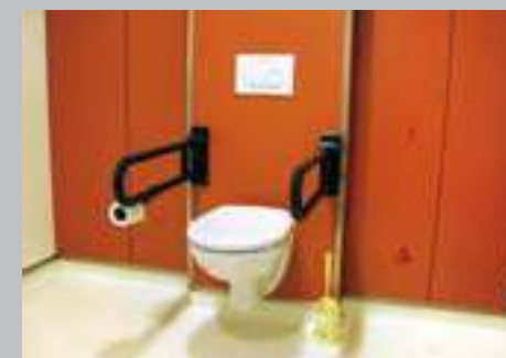
✓ Toilette adaptée disposant de 2 aires de transfert
