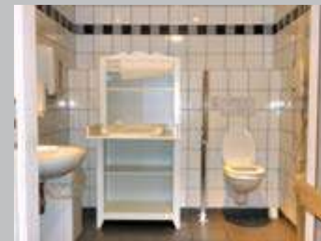
✗ Aire de transfert encombrée par table à langer et n'étant pas dans l'axe de la porte
