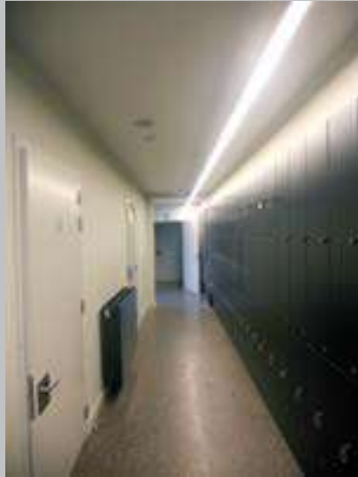
✓ Éclairage servant de ligne guide
