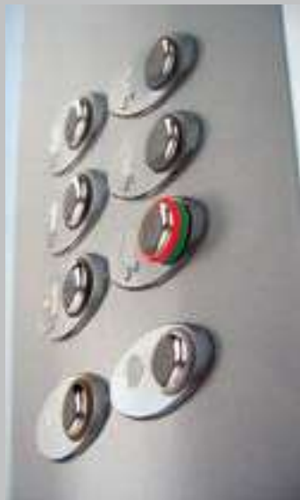
✓ Repères tactiles sur boutons d'ascenseurs
