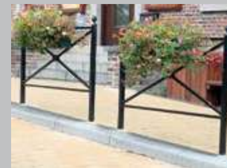
✔ Barrière contrastée et hauteur conforme
