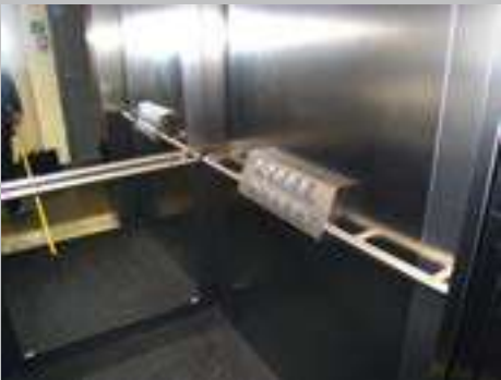
✓ Disposition correcte des boutons à l'intérieur de la cabine
