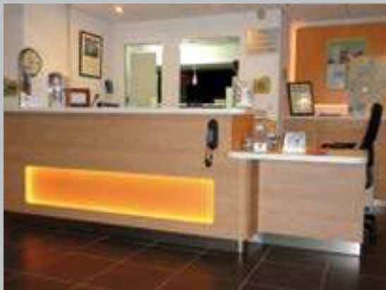
✗ Tablette surbaissée trop peu profonde
