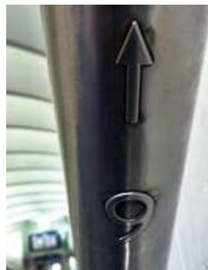
✓ Indications étage sur main-courante
